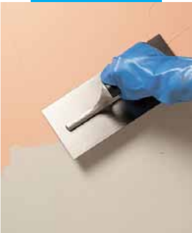
Effetto classico: applicazione della prima mano di Silexcolor Marmorino con spatola d'acciaio
