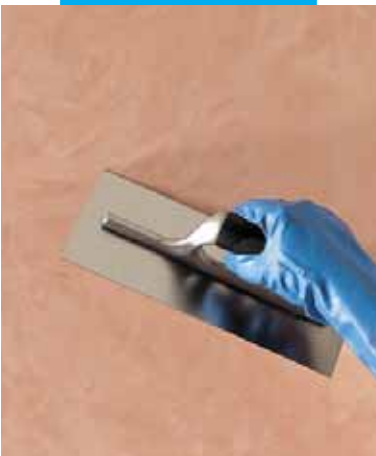
Effetto classico: lucidatura di Silexcolor Marmorino con taloscia d'acciaio tenuta a filo
