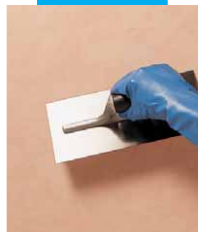
Effetto encausto: lucidatura di Silexcolor Marmorino con taloscia d'acciaio tenuta a filo
