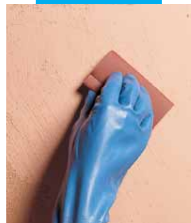
Effetto encausto: carteggiatura di Silexcolor Marmorino con carta abrasiva fine
