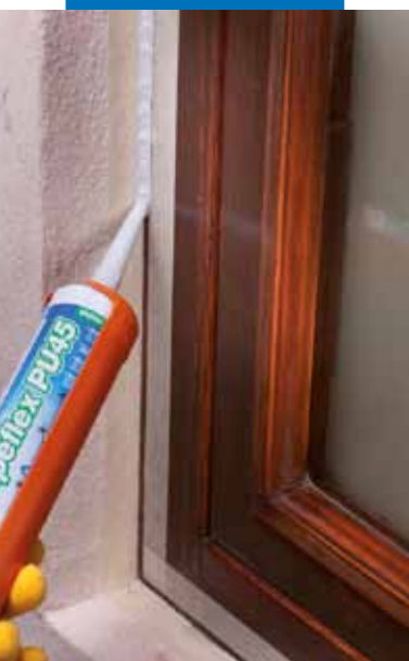
Sigillatura elastica di giunti di costruzione
