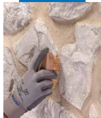
Rifinitura della superficie con spazzola di saggina
