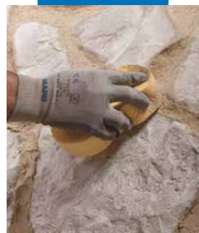
Rifinitura della superficie con spugna
