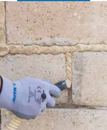
Rimozione della malta in eccesso
