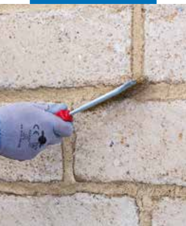
"Spazzolatura" dei giunti di malta
