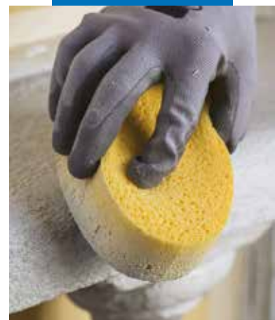
Frattazzatura con spugna di Mape-Antique Ecolastic
