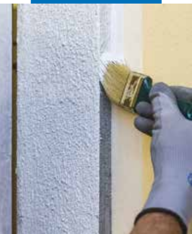
Protezione di cornice di una finestra con Mape-Antique Ecolastic
